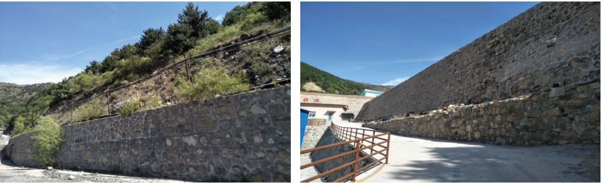
边坡治理工程
